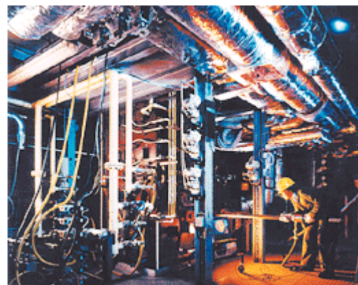
图7. PowerGen公司的燃烧试验装置（英国PowerGen公司特许刊登）
